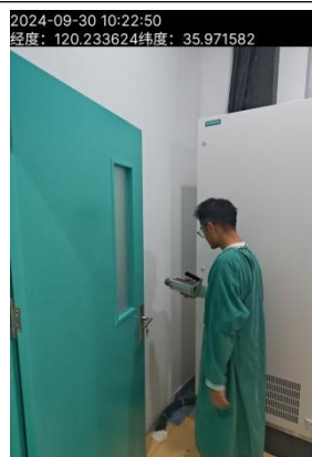
DSA 机房西墙配电室点位
